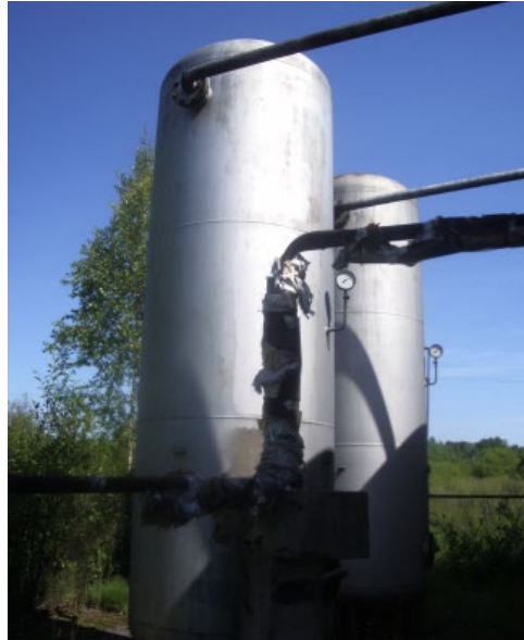
Рис. 10. Аэрационные баки ВОС пос. Вартемяги
